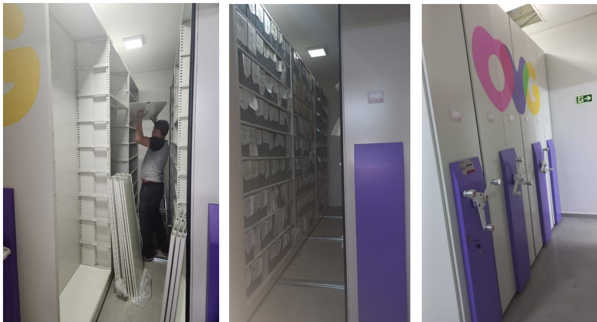
Montagem do Arquivo em Módulos Deslizantes e processo concluído
