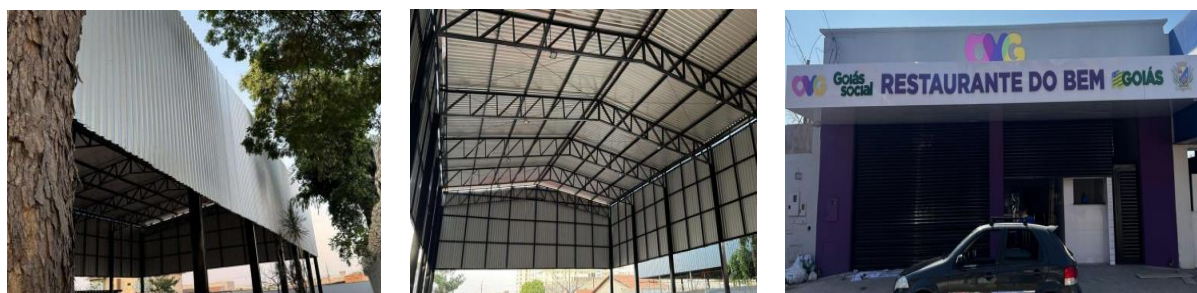
Fechamento Lateral Quadra Esporte EBV I e adequação Restaurante Minaçu
