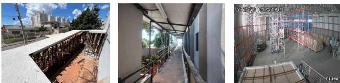
Rampa Acessibilidade EBV I e Galpão Moinho dos Ventos
