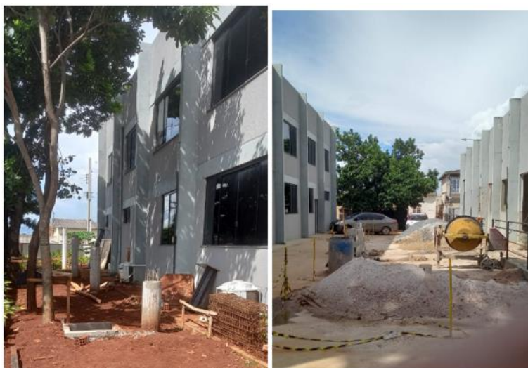
Obra de adequação no EBV I para implantação da modalidade Centro Dia
