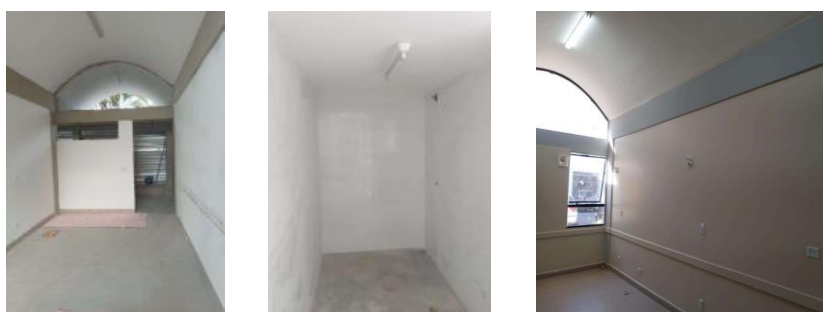
Reforma Leito ILPI - CISF
