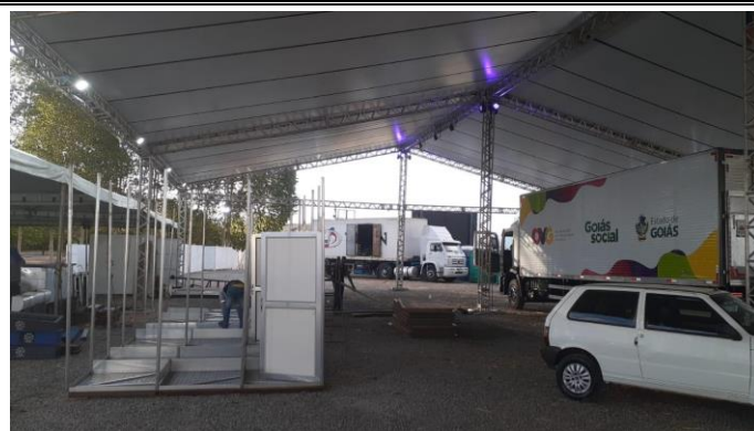
CAR Muquém: Montagem das salas de apoio das equipes operacionais
