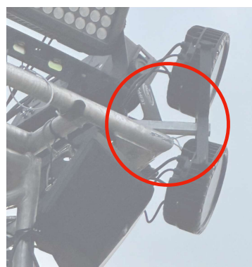
Representação de utilização do Greppo ou avanço metálico para fixação dos equipamentos
